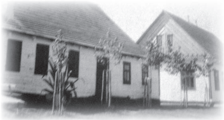
Шкільні приміщення 1956 р.
