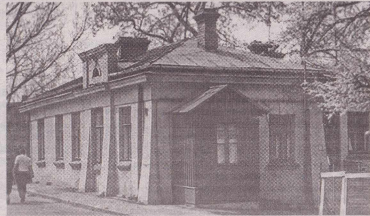
У цьому будинку на початку XX ст. була перша муніципальна електростанція, фото з книги О. Прищепи
