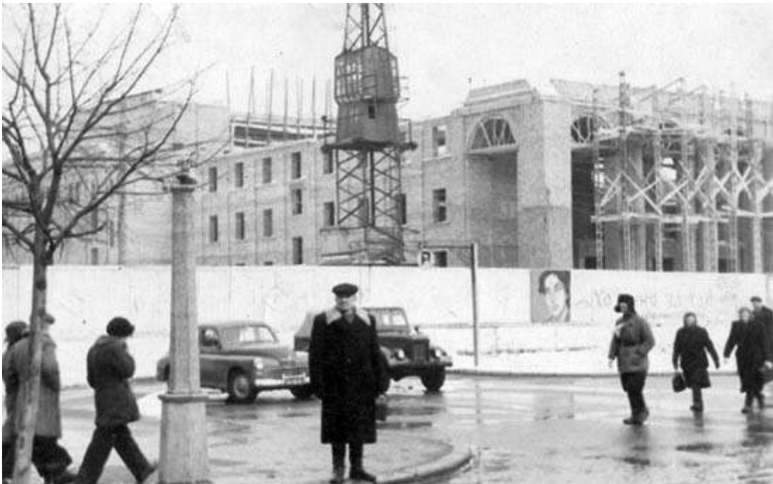
Будівництво театру 1958 рік
