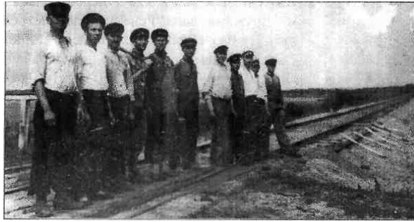
Бригада селян на ремонті залізниці, 1939 рік.
