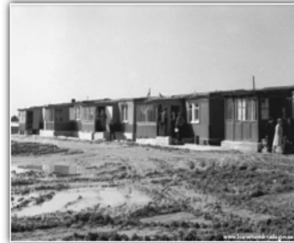
Офісні приміщення РАЕС
