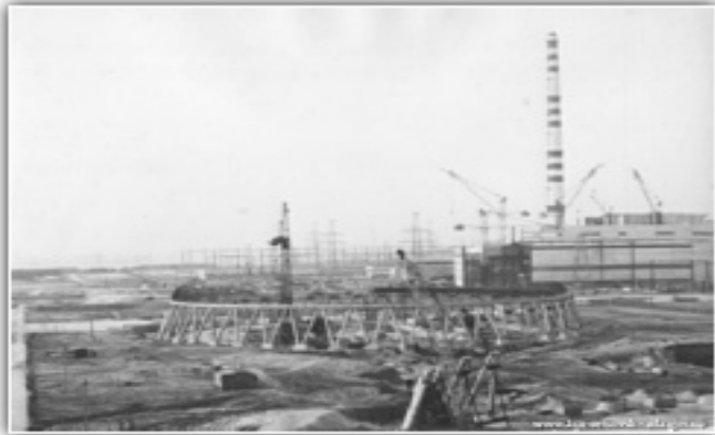
Будівництво градирні АЕС 1 енергоблоку РАЕС
