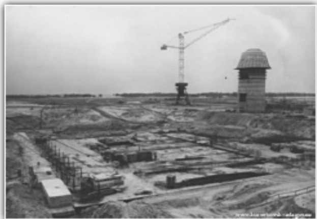
Початок будівництва енергоблоку №1
