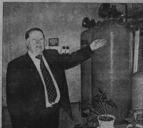
Директор Рівненського геріатричного пансіонату Василь Дрозд демонструє обладнання станції очистки води.
