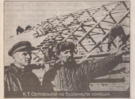
К.Т.Орловський на будівництві конюшні.
