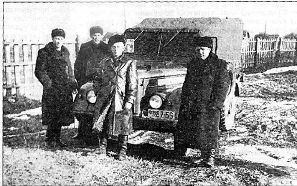
Степан (посередині у шкіряному пальті) на будівництві одного з об'єктів міжколгоспбуду.
