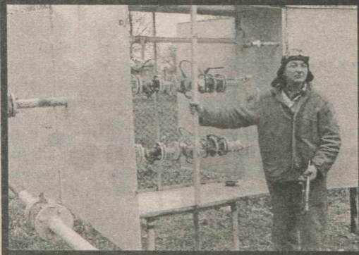
На фото: під час пуску газопроводу.
