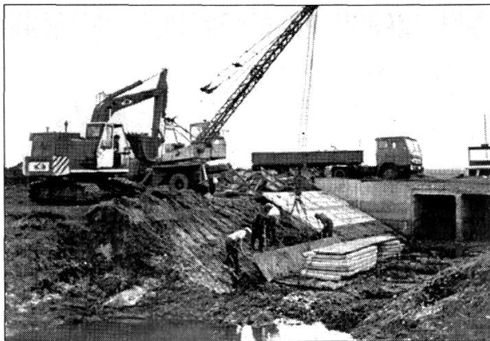
Будівництво меліоративного каналу.
