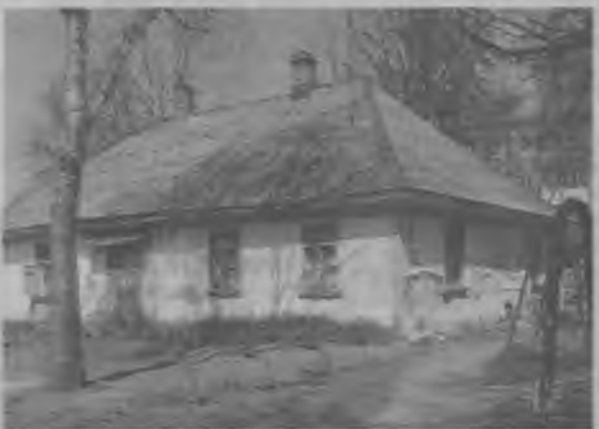
Будинок, де жила сім'я Носалів, знесений. Фото поч ХХІст.
