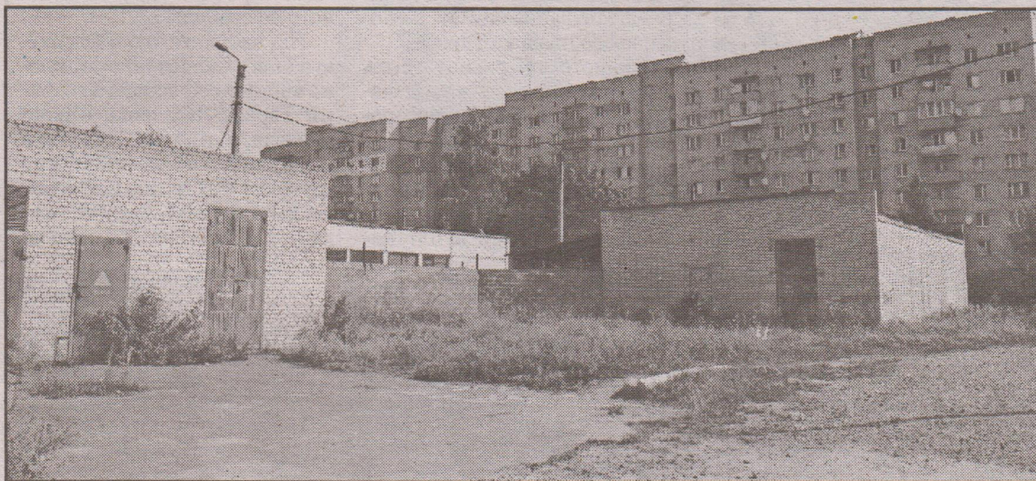
Від трансформатора залишилося лише порожнє місце.
