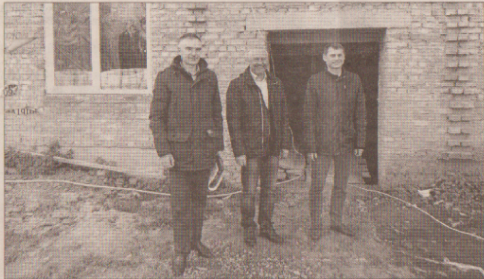
На будівництві ДНЗ у Новомильську.
